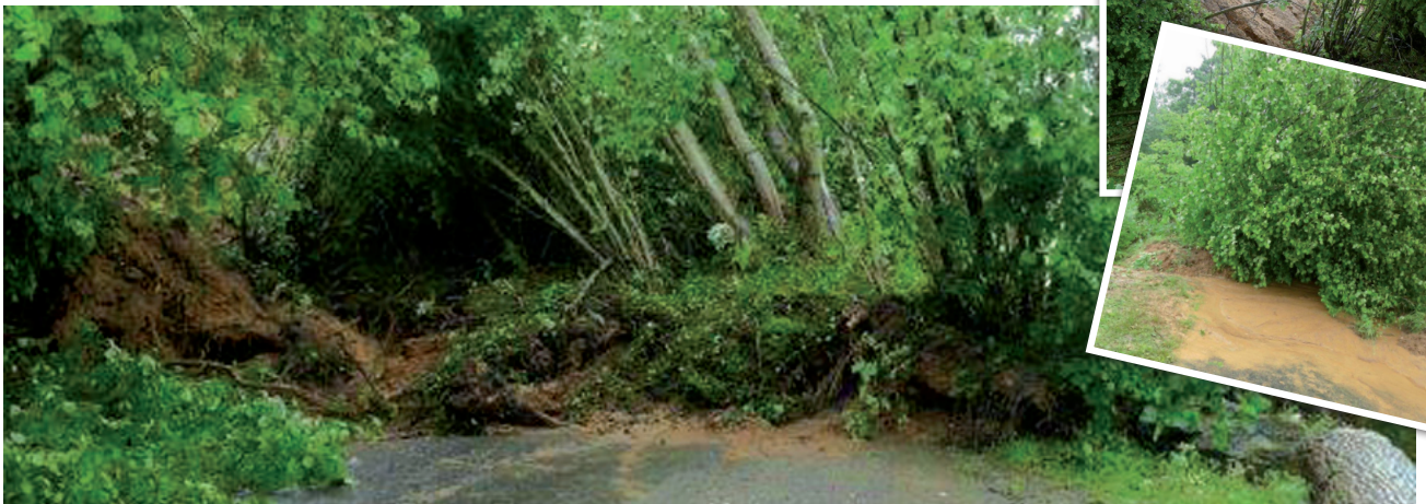
A cause des intempéries, un glissement d'un talus s'est produit Route de Vernelle.
